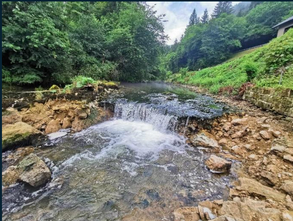
Vue du seuil de l'Engoulot éventré
