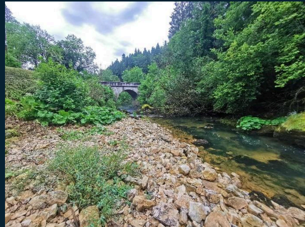
Vue aval seuil, et relargage blocs et sédiments
