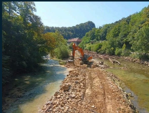
Avant l'arrêt du chantier jeudi 22 août
