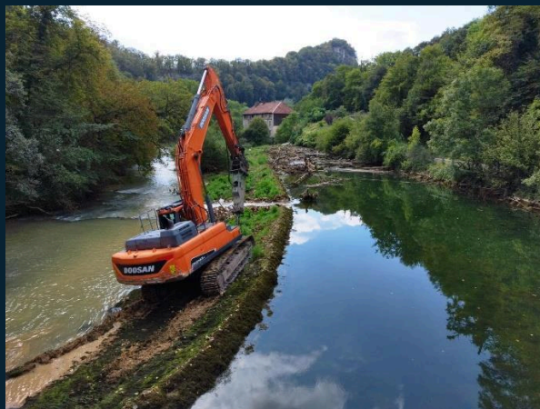
Démarrage des travaux mardi 20 août
