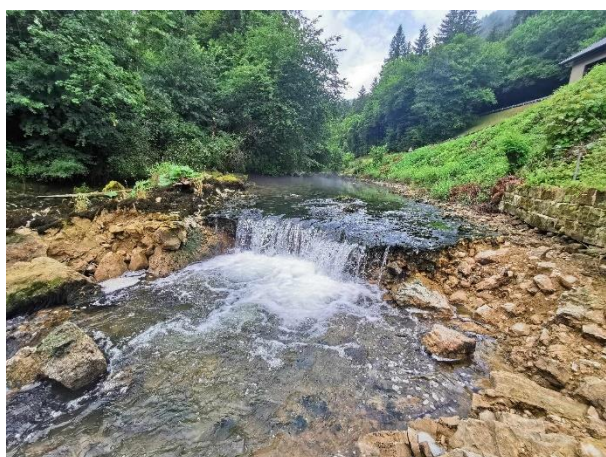
Vue du seuil de l'Engoulot éventré
