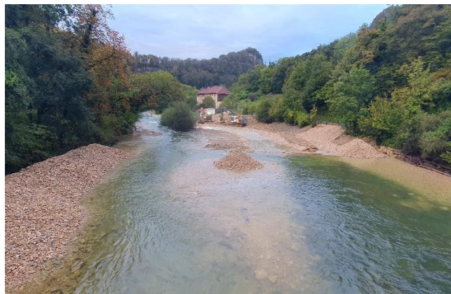
Chantier le 27 septembre, mis en eau des 2 chenaux
