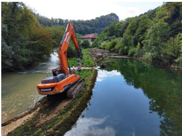
Démarrage des travaux mardi 20 août
