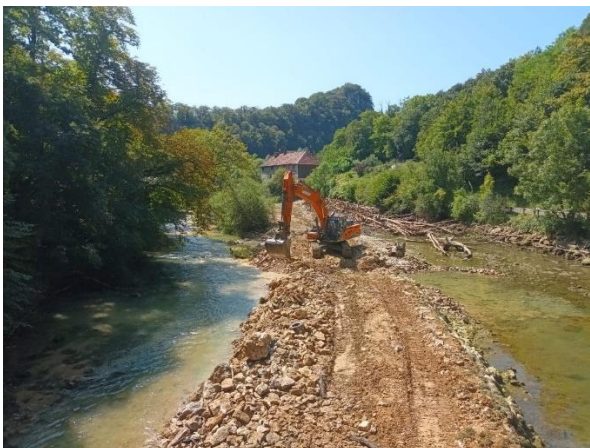
Avant l'arrêt du chantier jeudi 22 août
