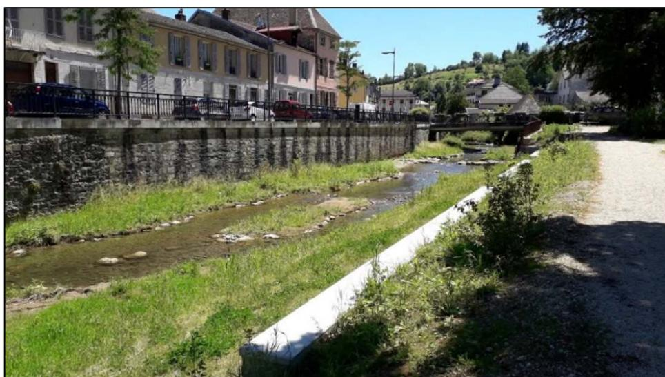
Figure 63- Exemple de banquettes sur la Furieuse à Salains-les-Bains (Artelia, 2020)
