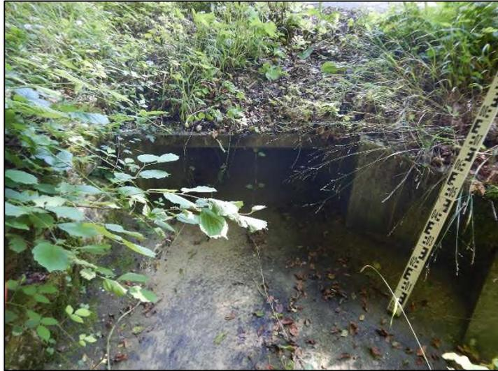
Figure 40 - Dalot permettant le franchissement du ruisseau de Creuse sous la route
