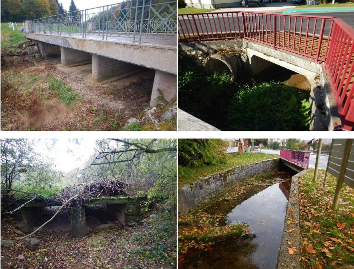
Figure 68 – Exemples de ponts-cadre sur le ruisseau d'Hautpré, de Voye et de la Baume (photos prise le 13, 18 et 20/10/2022)
