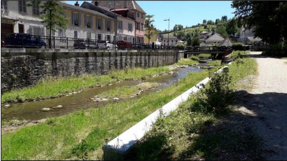
Figure 142- Exemple de banquettes sur la Furieuse à Salins-les-Bains (Artelia, 2020)
