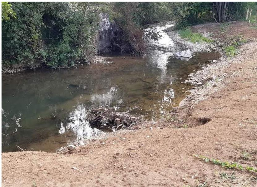
Figure 144 – Exemples de banquettes en branchages et de souche sur la Glantine à Tourmont (Artelia, 2023)
