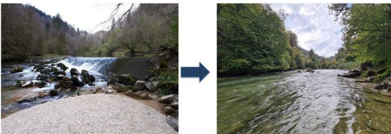
Figure 145 – Effacement de seuils sur le secteur aval du Dessoubre – Photos du radier des seuils avant aménagement (à gauche) et post aménagement -(Artelia, 2018-2023)
