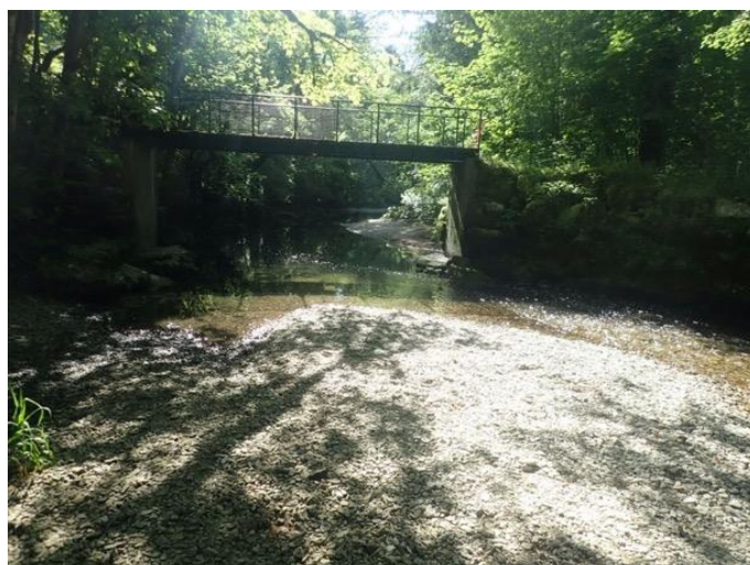
Passerelle de Vermondans
