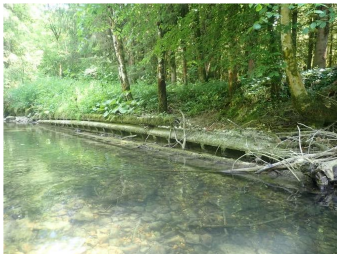
Protection de berge en poteau EDF
