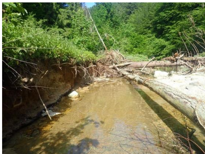
Erosion de berges et arbres en travers
