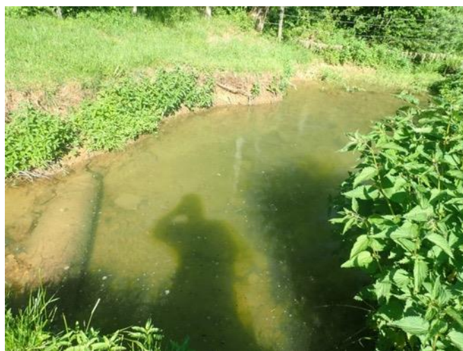
Altération du lit en amont du pont de Martinvaux
