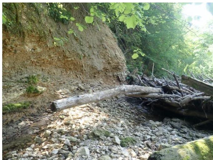
Erosion de berge liée à la présence de l'embâcle
