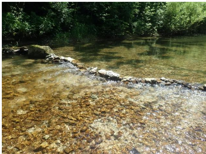
Seuil en pierre non problématique
