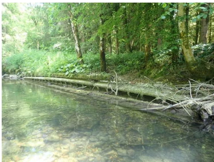
Protection de berge en poteaux béton EDF au niveau de Gigot
