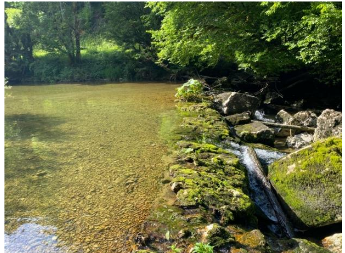
Seuil n°7 cloisonnant le cours d'eau
