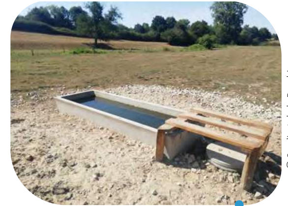
Abreuvoir gravitaire alimenté par retenue d'eau
