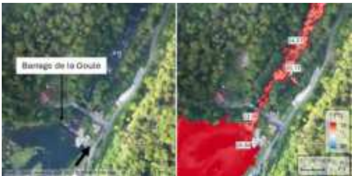
Figure 110 : Mosaïque thermique et orthophoto illustrant la légère baisse des températures observée au niveau du barrage de la Goule.
