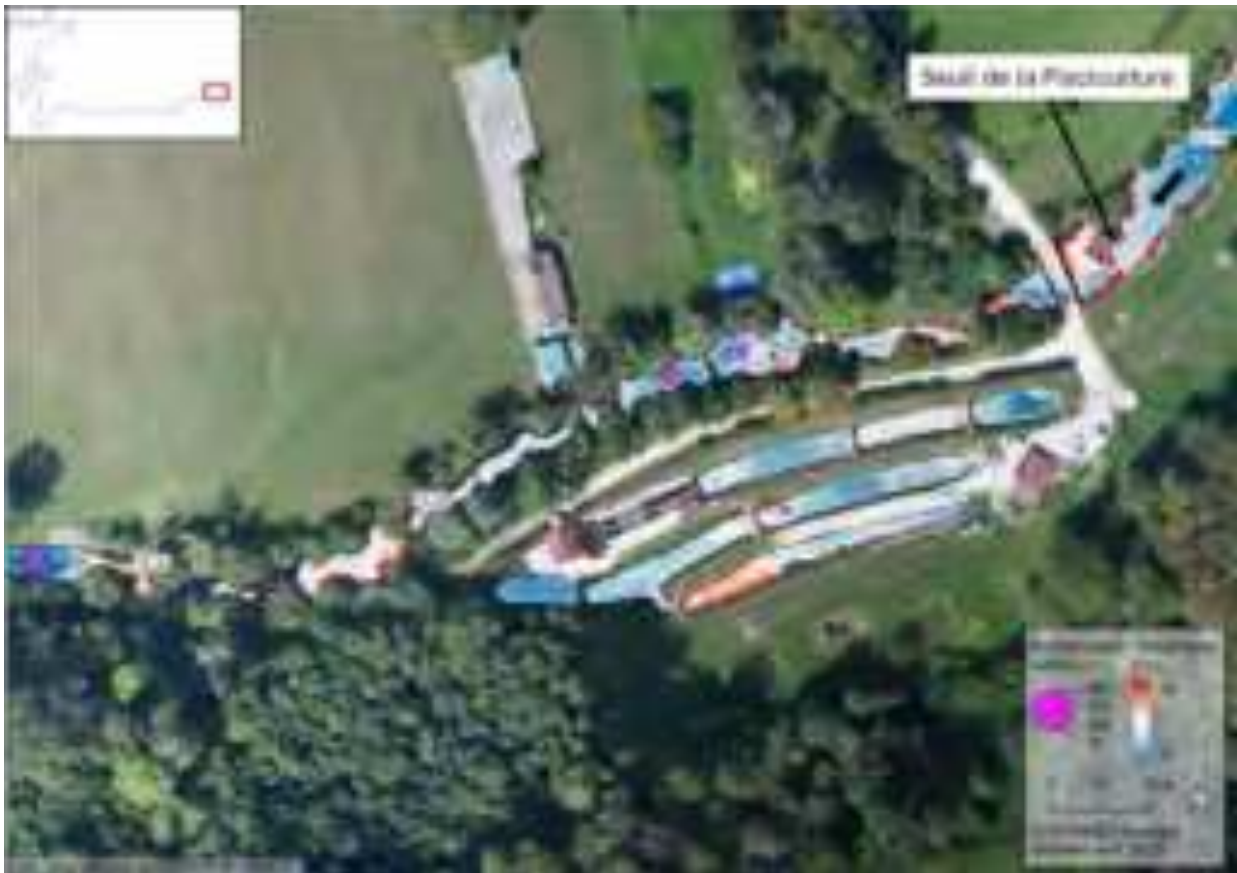
Figure 13 : Mosaïque thermique et orthophoto illustrant le réchauffement observé au niveau de la pisciculture de Cusance (zone C_Cu1).
