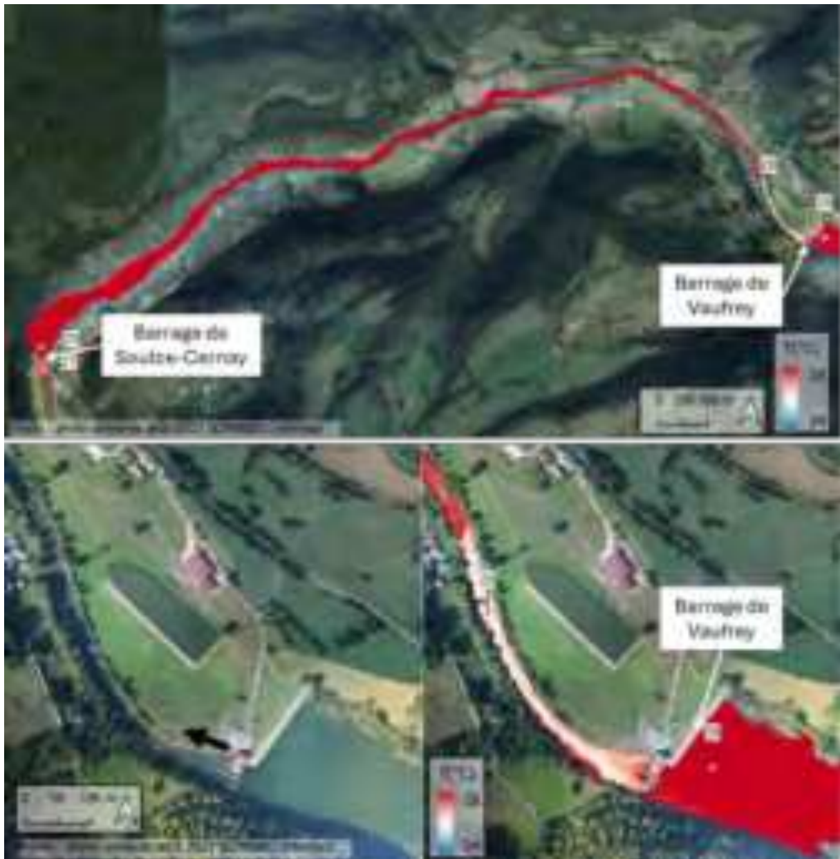
Figure 123 : Mosaïque thermique et orthophoto du tronçon compris entre les barrages de Vaufrey et de Soulce-Cernay montrant l'emprise de la retenue de Soulce-Cernay et la légère baisse de température à l'aval du barrage de Vaufrey. En bas : zoom sur l'aval du barrage de Vaufrey.
