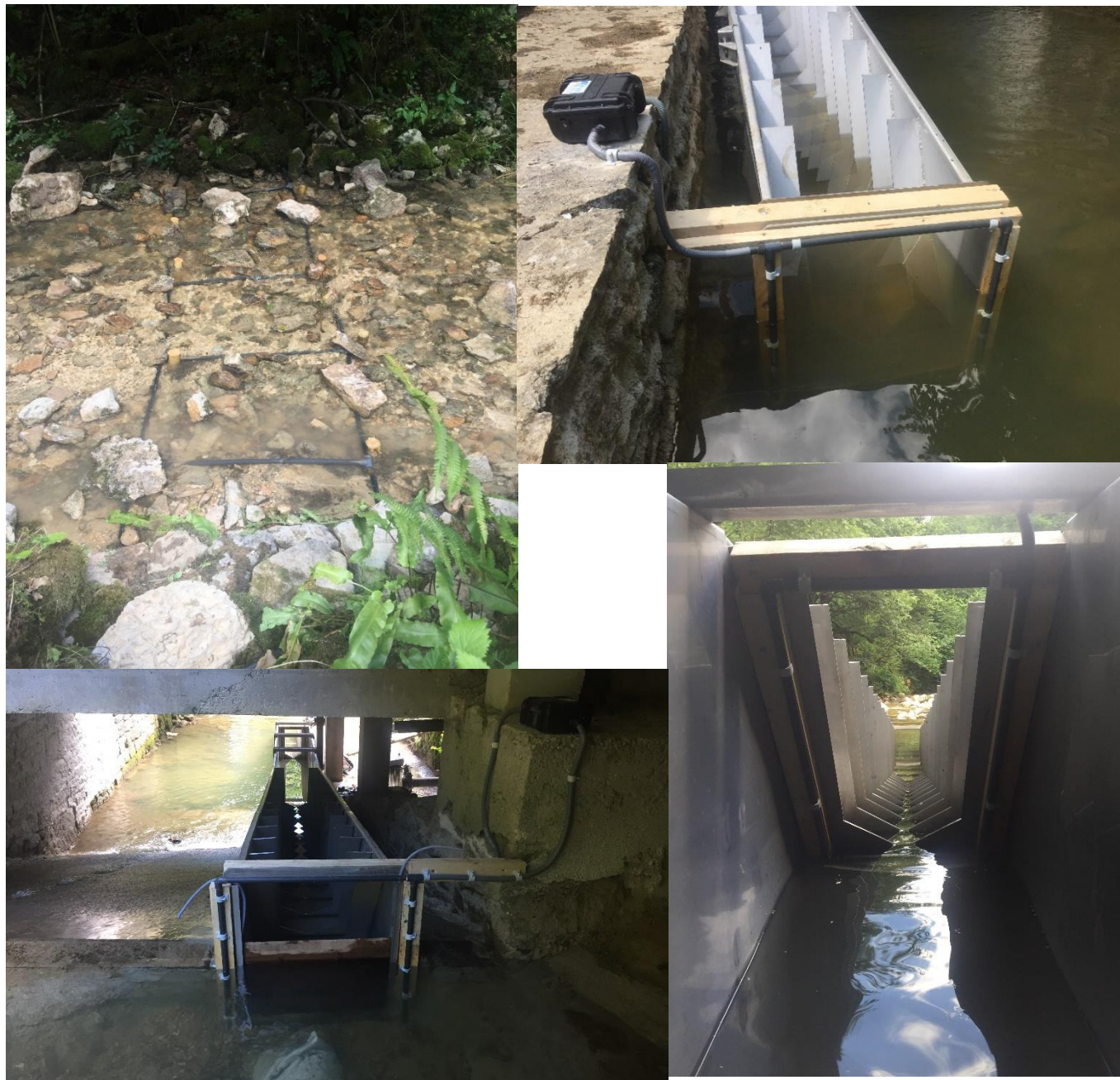
Figure 13 : Les quatre antennes implantées : en haut à gauche, l'antenne 1 en aval du site. En haut à droite, l'antenne 2 en entrée de passe (aval). En bas à droite, l'antenne 3 en milieu de passe. En bas à gauche, l'antenne 4 en sortie de passe (amont).
