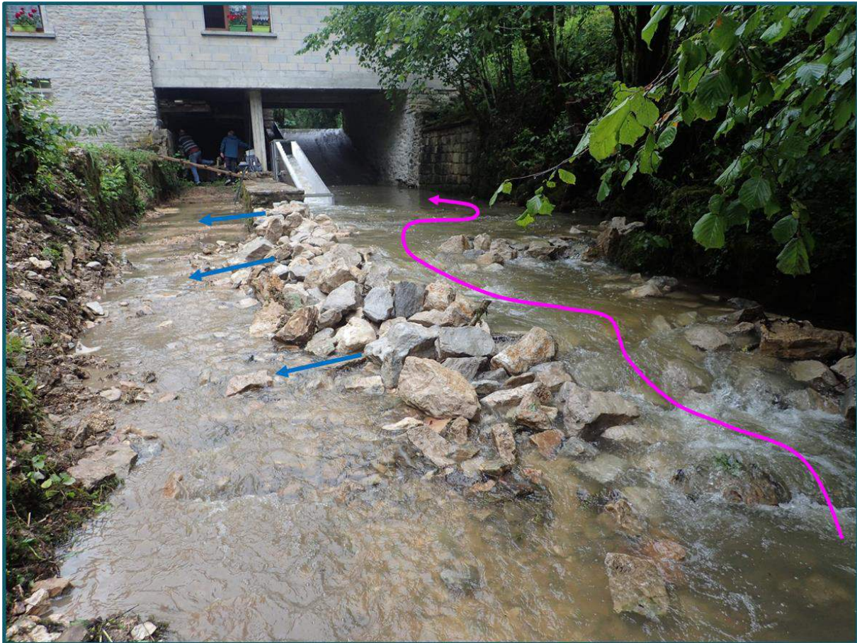
Figure 5 : Aménagements de la partie aval du seuil. La flèche violette indique le chemin de montaison créé par l'aménagement.
