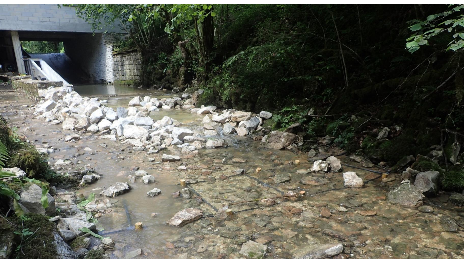
Figure 15: Site d'étude, de l'aval. L'antenne 1 est au premier plan.
