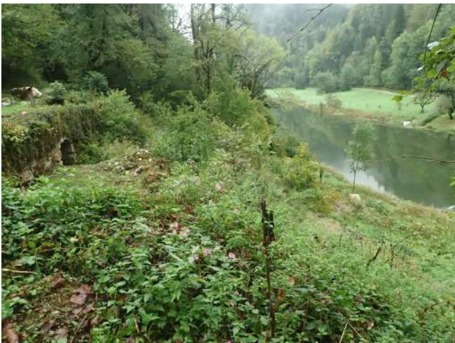
Zone 1 difficile d'accès à l'amont du barrage de la Goule
