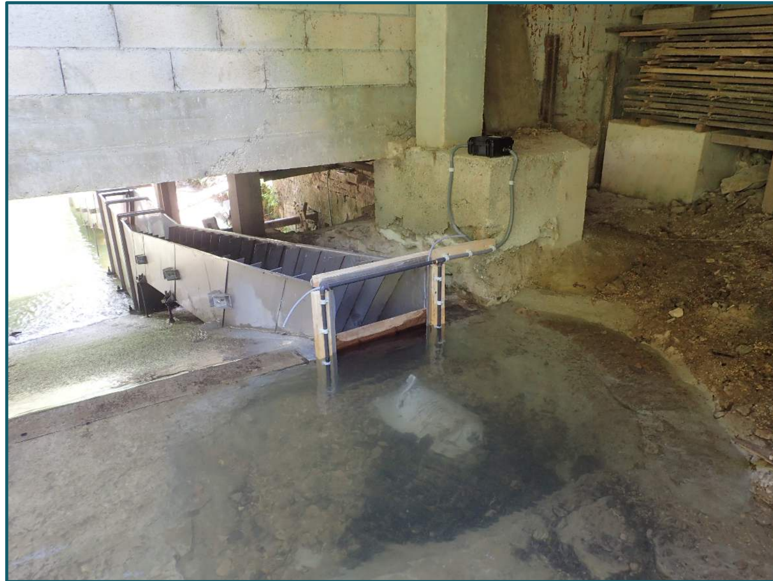
Antenne n°4 en sortie de la passe / Antenne Nr. 4 am Ausgang des Passes
