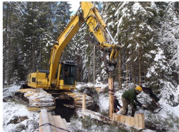
**Figure 8 : Pose de barrage sur fossés de drainage dans le cadre du 1er programme LIFE sur le site des Guinots**
